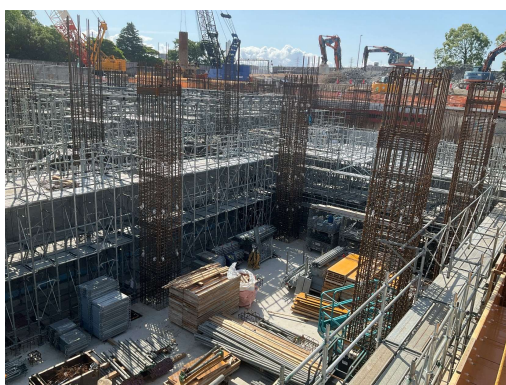
工場棟地下1階躯体工事施工状況（南側）
