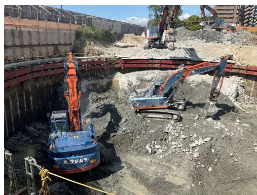
煙突基礎解体工事施工状況
