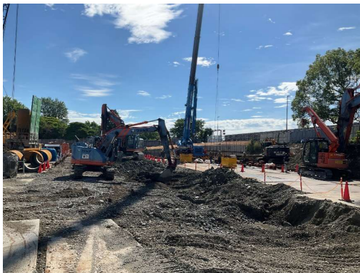
テント基礎解体工事施工状況（南側）
