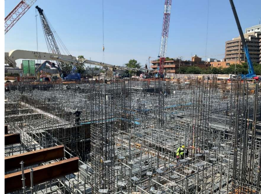
工場棟地下1階躯体工事施工状況
