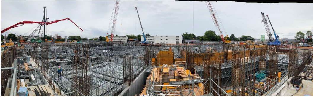
工場棟全景（西側）
