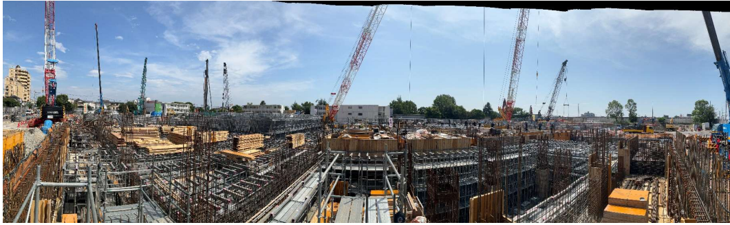
工場棟全景（西側）
