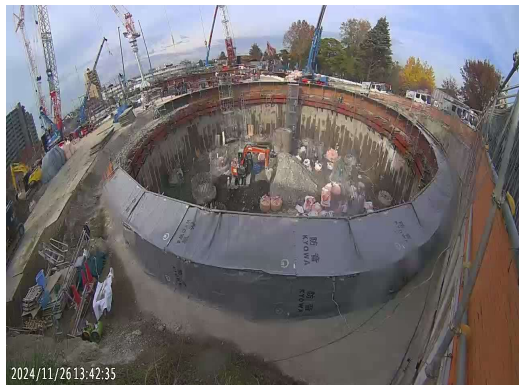
煙突掘削工事施工状況
