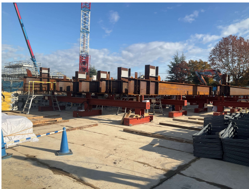
南ヤード地上鉄骨鉄筋地組状況
