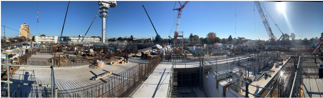
工場棟躯体工事1階床施工状況（西側）
