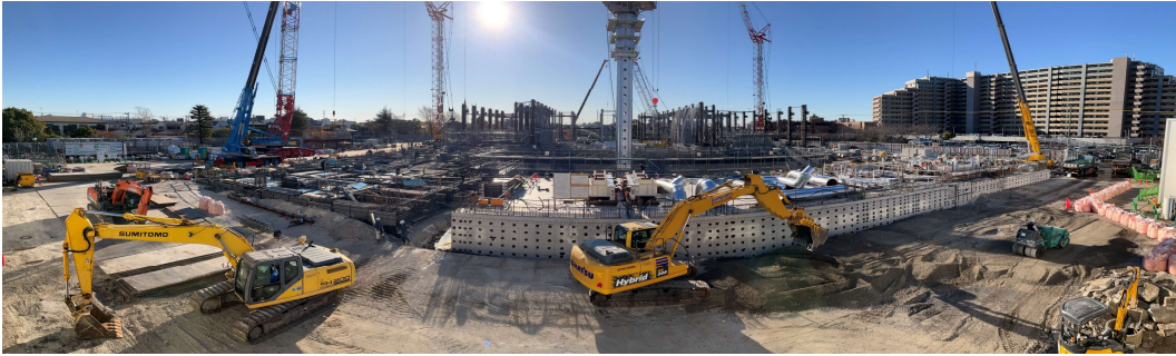
工場棟1階床躯体工事施工状況（北側）
