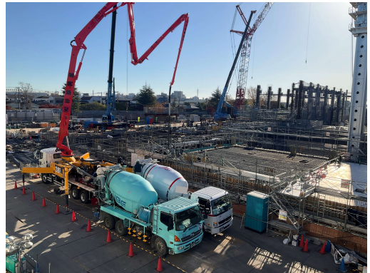
工場棟1階床躯体工事コンクリート打設状況(北側)
