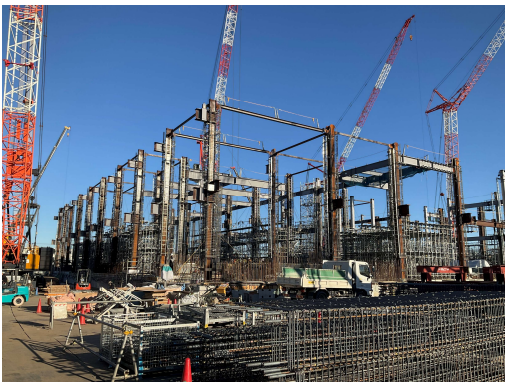
工場棟地上躯体工事施工状況(南西側)
