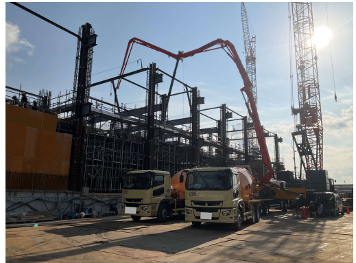
工場棟1階躯体工事コンクリート打設状況(西側)
