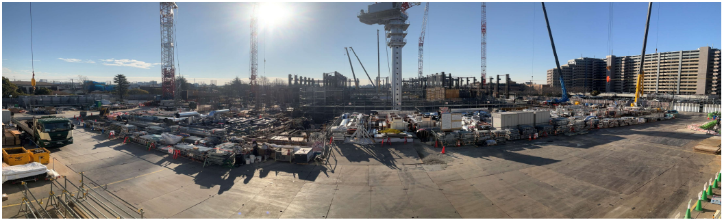
工場棟1階躯体工事施工状況（北側）
