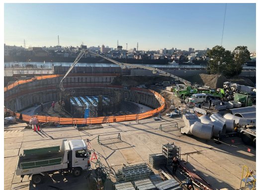
煙突基礎躯体工事コンクリート打設状況
