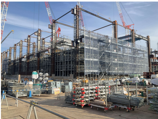
工場棟地上躯体工事施工状況(北西側)
